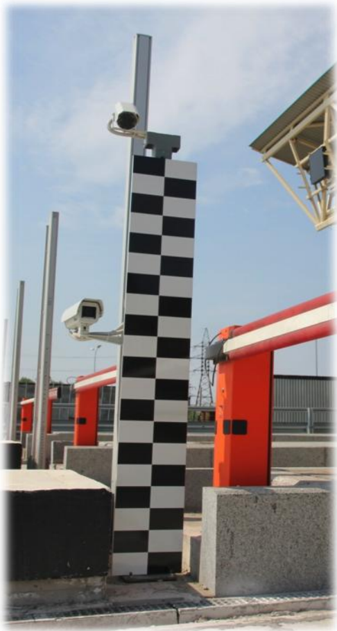
Сенсорная система видеочамера, инфракрасный калибровочный щит (для противоположной чамеры)
